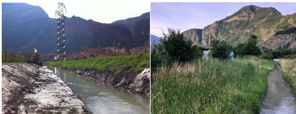
Fig. 28. Reprofilage de la meunière (à gauche, 28 mars 2017), de façon à créer une forme de lit majeur à fleur d'humidité, permettant l'installation d'une végétation riveraine diversifiée (à droite, 8 juin 2022). Le lit mineur a été maintenu pour favoriser la circulation des limons et éviter des dépôts trop importants.
